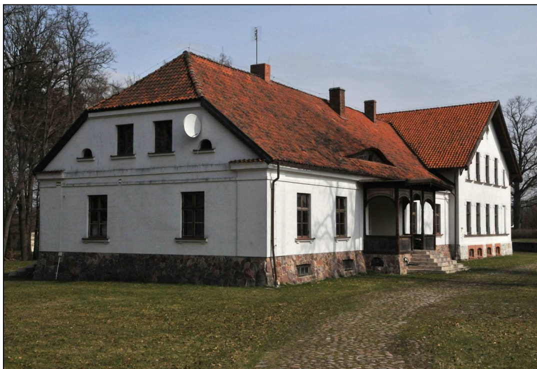
Dwór neoklasycystyczny z początku XIX w., rozbudowany w 1898 r.
