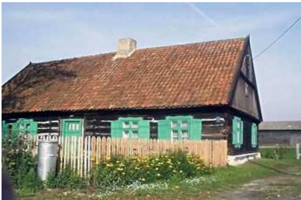
Chałupa z drugiej połowy XIX w. Drewniana na podmurówce z kamieni polnych, węglowany na tzw. jaskółczy ogon, usytuowana kalenicowo do ulicy. Od frontu cztery otwory okienne i jeden otwór drzwiowy, w ścianie szczytowej dwa okna od wschodu, a od zachodu jedno okno normalne i drugie stanowiące połowę pierwszego. Dach dwuspadowy kryty dachówką, szczyty deskowane.
