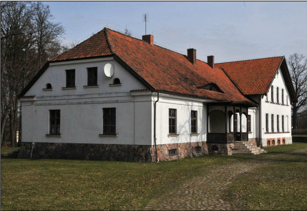
Dwór neoklasycystyczny z początku XIX w., rozbudowany w 1898 r.
