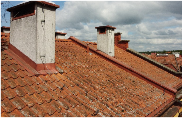
Dach ZZOZ przed modernizacją; z arch. Wydziału IRL
