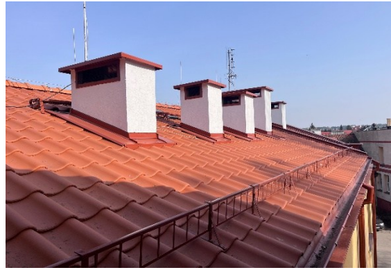
Dach ZZOZ po modernizacji; z arch. Wydziału IRL
