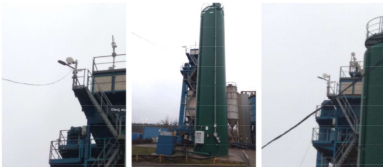
Widok obiektu wraz z zainstalowanym zespołem antenowym
