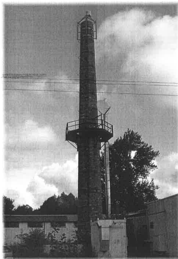
Fot. 1. TON Olsztyn / Barczewo – widok komina z antenami
